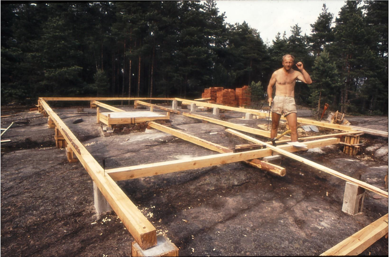
Martti Soikkeli kertoi erityisen paljon pitäneensä kädentaitoja vaativissa rakennustyöissä. Kuva perheen kesäasunnon rakennustyömaalta Kustavi 1973.MS.
