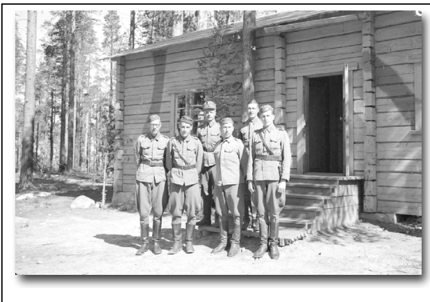
Pioneerikomppanioiden komentopaikka ja sen päällystyö. Rukajärven suunta SA-kuva 25.7.1943.
