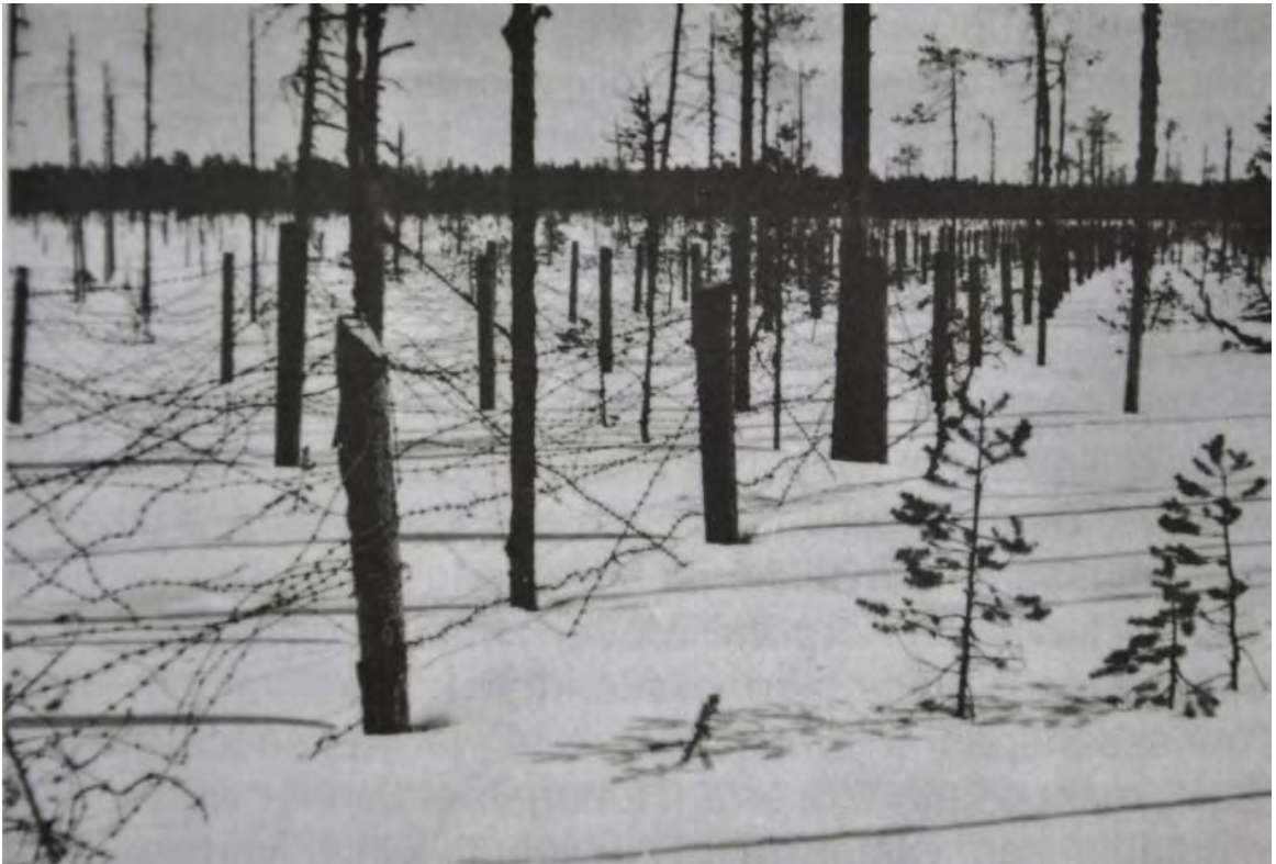
Piikkilankaeste KV "Haravan" ympärillä. Esteen ulkopuolella on aukoton putkimiinakenttä ja hälyttimet (kuva Pentti Perttuli)
